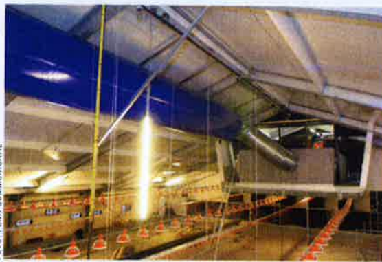
Inpandige warmtewisselaar in pluimveestal, een 'end of pipe'-oplossing om emissie van fijn stof te reduceren.
